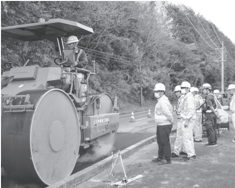
アスファルトを転圧する工程を見学
